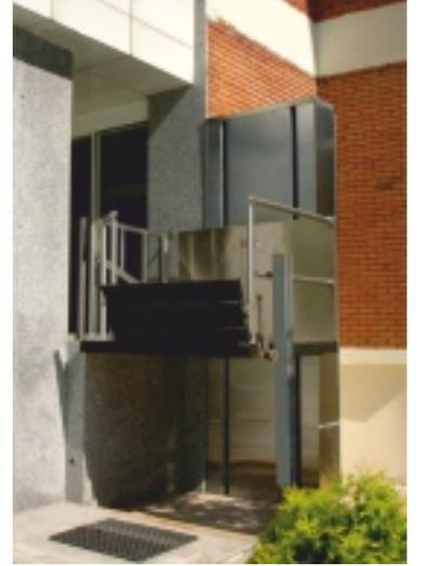
Engelli asansörleri makaslı platformlar şeklinde de üretilmektedir. Makaslı platformlar kısa seyir mesafeleri için uygun çözümlerdir.
